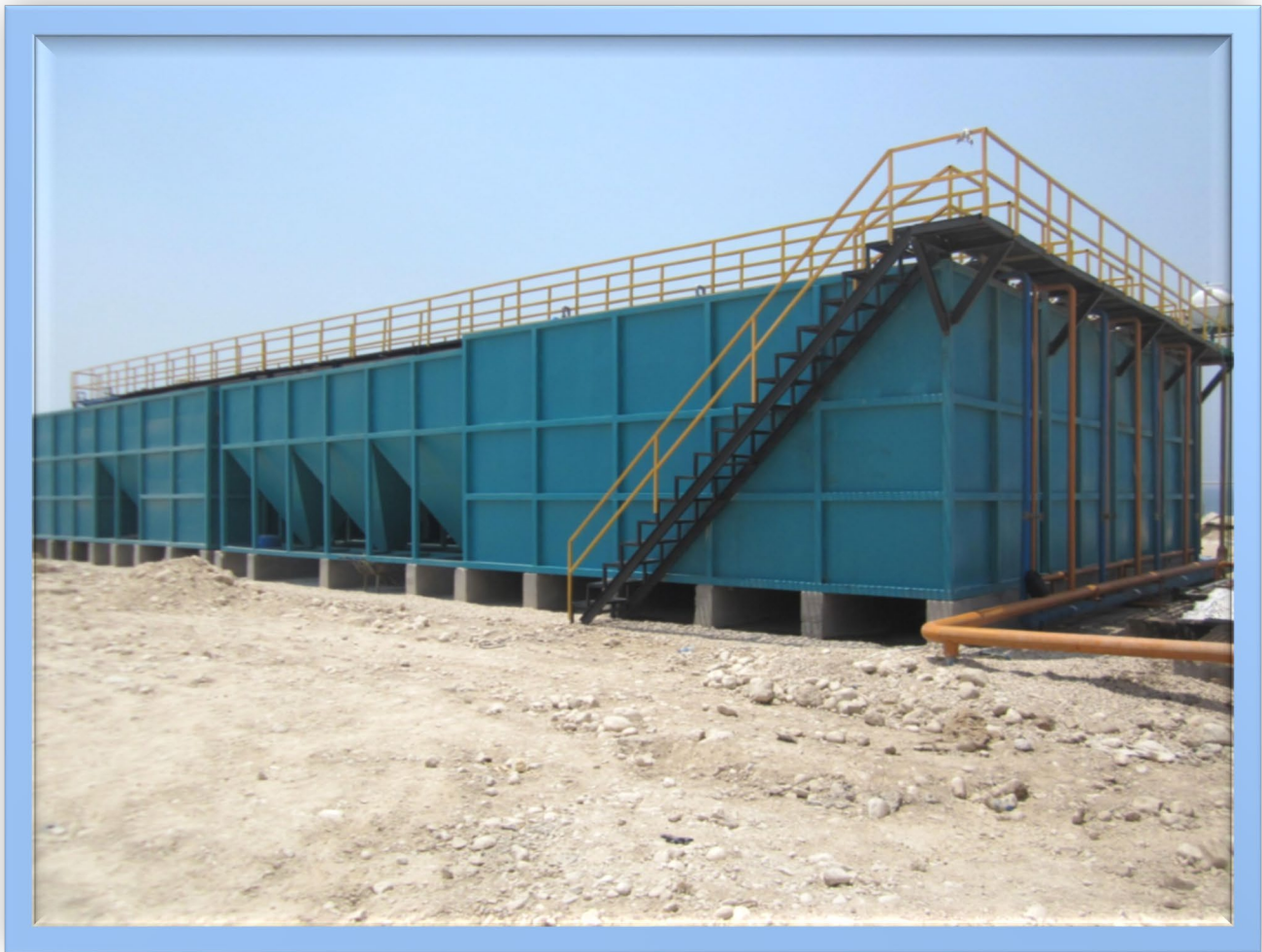
پروژه پارس جنوبی (فاز ۱۳)
