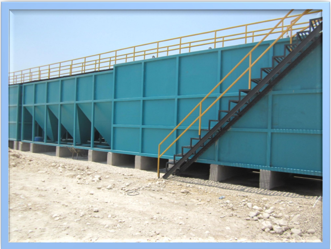
پروژه پارس جنوبی (فاز ۱۳)
