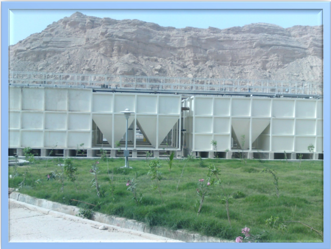
پروژه پارس جنوبی (فاز ۱۲)
